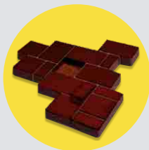
Расшатывание брусчатки и западание отдельных плит
