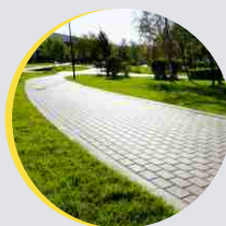
Прокладывание пешеходных зон
